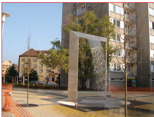
První část rekonstrukce Karloviny
